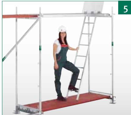
Innenliegenden Leitengang auflegen.
